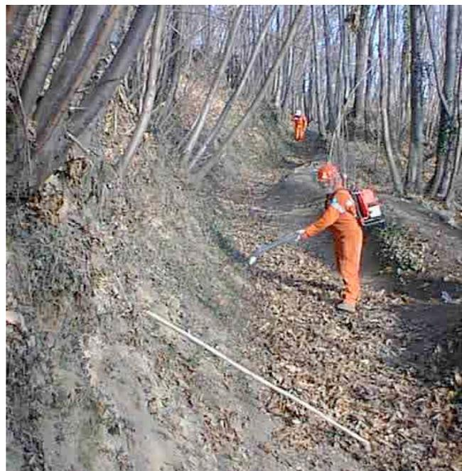
*Fig. 2.7: Lavori di mantenimento dei tracciati tagliafuoco*
